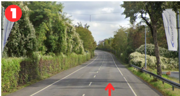
Überfahrt der Continentalbrücke
